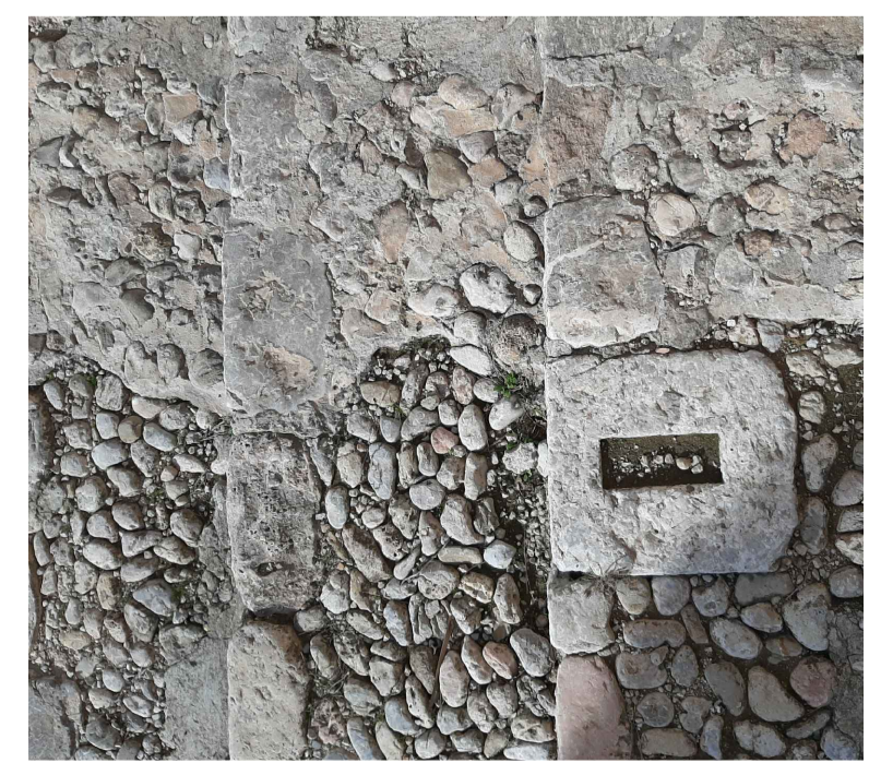
Pavimento existente y pieza de piedra a reutilizar
