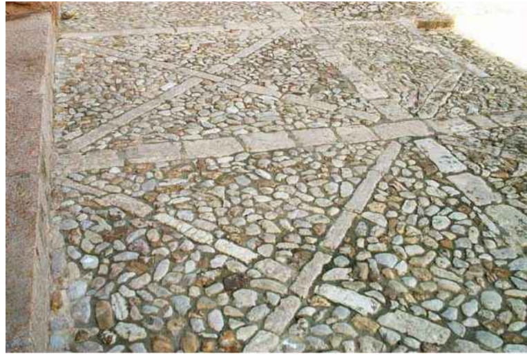
Pavimento de canto rodado entre recercado de piedra tipo "Enmacat"
